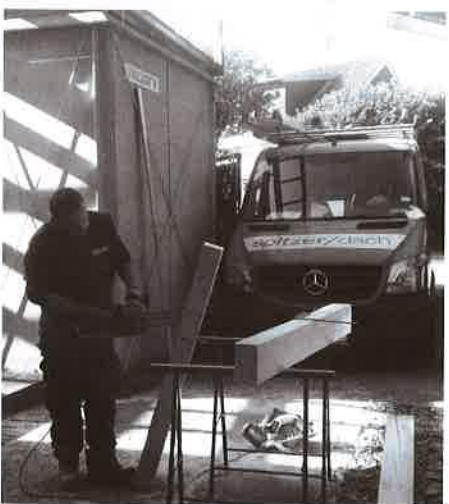
Die Firma Spitzer Dach ermöglichte tolle neue Überdachungen im VinziDorf Graz.
